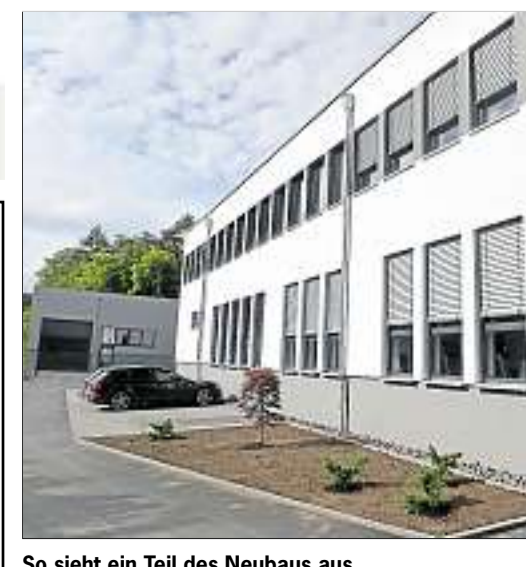
So sieht ein Teil des Neubaus aus.
